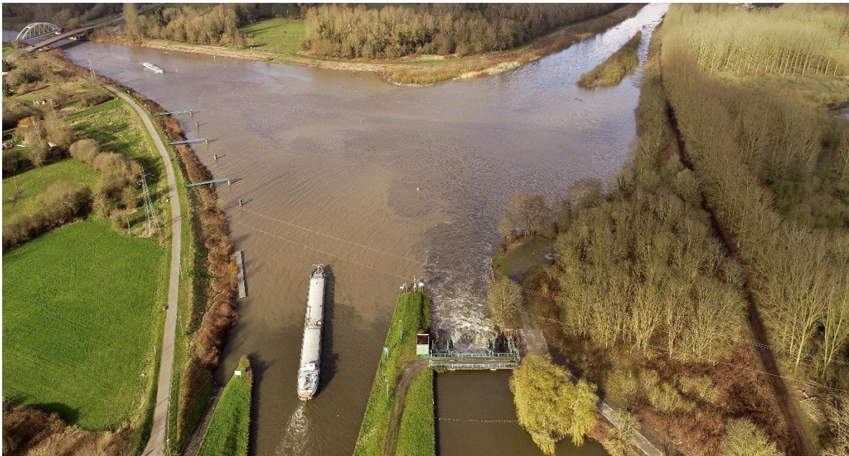
Le canal de Condé-Pommerœul depuis la jonction avec l'Escaut (© VNF / P.Houze)
